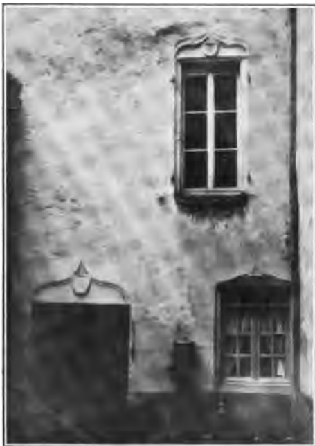
ALENÇON. — Maison Coureyeur. ■ Cliché de M. Picrr: Giraud.
